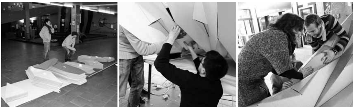
Abb. 10: Aufbau der Origamistruktur aus Wellpappsegmenten
